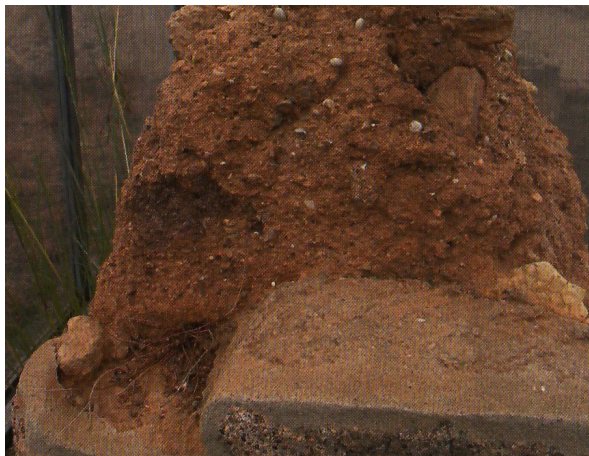
Solunto: dettaglio del muro di mattoni crudi vano XII insula 7
