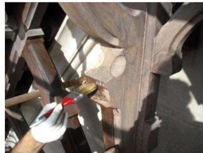
Spazzolatura e carteggiatura delle vernici polverizzate e cretate, trattamento antiparassitario e protezione finale con adeguato protettivo della capriata lignea del corpo centrale
