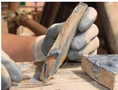
Riadesione di frammenti o commenti di fratture mediante fissaggio e stuccatura finale con resina epossidica bicomponente adeguatamente caricata
