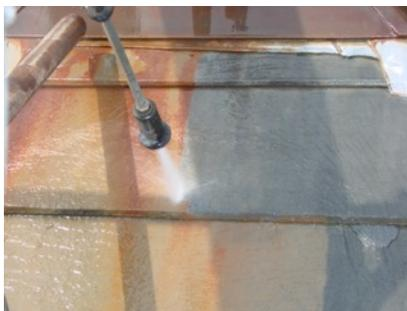
Pulitura dei depositi superficiali coerenti, macchie da ossidazioni metalliche ed incrostazioni mediante irrorazione di acqua, impacchi
