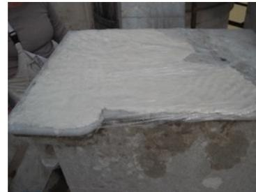
Consolidamento corticale in presenza di disgregazione della superficie lapidea tramite impregnazione con idoneo consolidante e in profondità in
