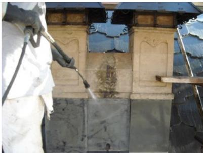
Disinfezione delle superfici lapidee interessate da microflora con applicazione a pennello di idoneo biocida a largo spettro; rimozione dei depositi superficiali coerenti, incrostazioni, concrezioni e macchie solubili mediante irrorazione con acqua e successiva rifinitura con spazzolini, spugne e bisturi di precisione; consolidamento in profondità di lesioni e fratture con infiltrazioni e stuccatura finale con malta a base di calce e inerti a granulometria selezionata di adeguata cromia.
