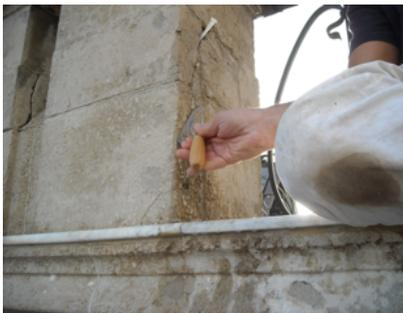
Smontaggio della colonnina in pietra a supporto del parafulmine del prospetto ovest; disinfezione a pennello con biocida a largo spettro e pulitura della superficie con irrorazione di acqua, ricostituzione ancoraggio anima in ferro con malta a base di calce e successivo rimontaggio della colonnina.
