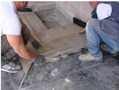
Rimontaggio manto in ardesia, previo rifacimento di strato impermeabilizzante e verifica sistema smaltimento, mediante ricollocazione delle lastre con malta a base di calce e puntuali imperniature
