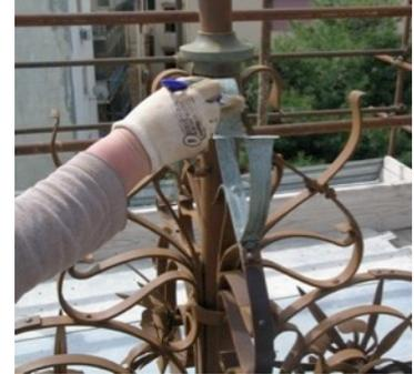
Rimozione dei depositi superficiali coerenti, delle concrezioni, dei prodotti di ossidazione o delle vernici di superfetazione mediante l'ausilio di micromotori con dischi e spazzole abrasive o sverniciatori ecologici e lavaggio finale con alcool denaturato per l'eliminazione dei residui.
