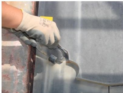
Verifica funzionamento sistema di illuminazione dell'intradosso delle falde del corpo centrale, smontaggio e pulitura bicchieri in vetro e sostituzione lampade danneggiate
