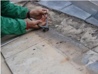
Smontaggio manto in ardesia; pulitura mediante spugnature di acqua e rimozione meccanica del fronte e del tergo delle lastre in buono stato di conservazione e sostituzione di quelle danneggiate
