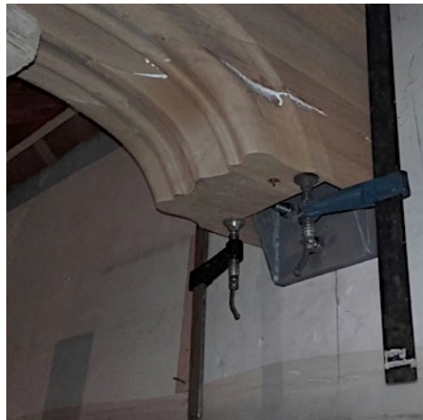
Fasi del montaggio tramite idonei ancoraggi al soffitto ligneo del vano dello scalone principale
